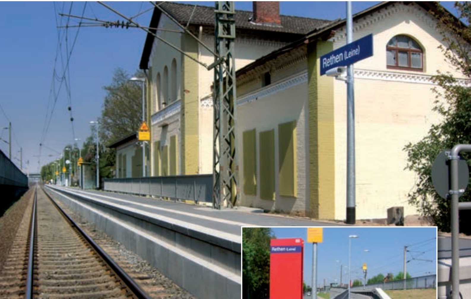
Bahnsteigbau in Hannover-Rethen
