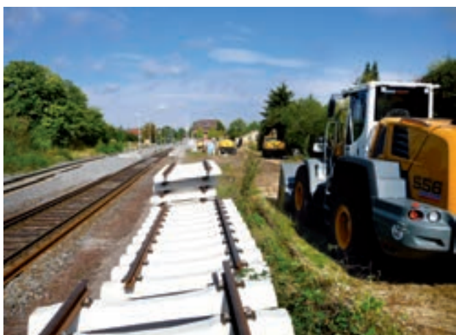
Neubau der Gleise im Bahnhof Ahnatal-Weimar
