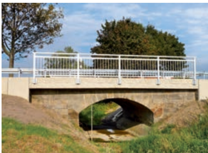
Natursteinbrücke bei Barsinghausen einschließlich Straßenbau
