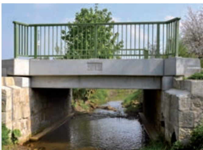
Erneuerung der Brücke in Wallensen mit einem Überbau aus Stahlbeton
