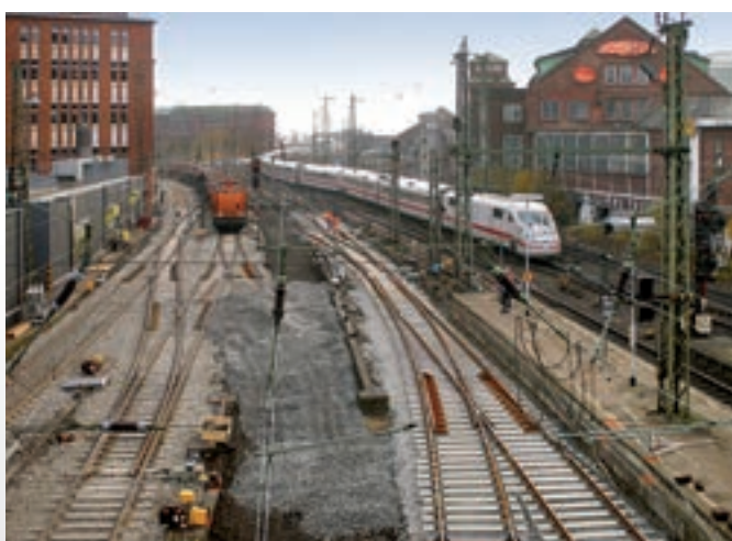
Auswechslung von Gleisen und Weichen im „Südkopf“ des Hamburger Hauptbahnhofes
