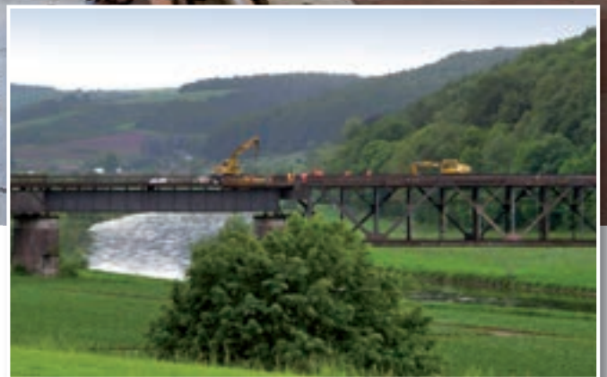
Brückenbalkenerneuerung auf der Weserbrücke bei Lauenförde
