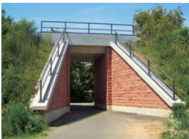
Eisenbahnbrücke mit Natursteinverblendung in Groß-Umstadt
