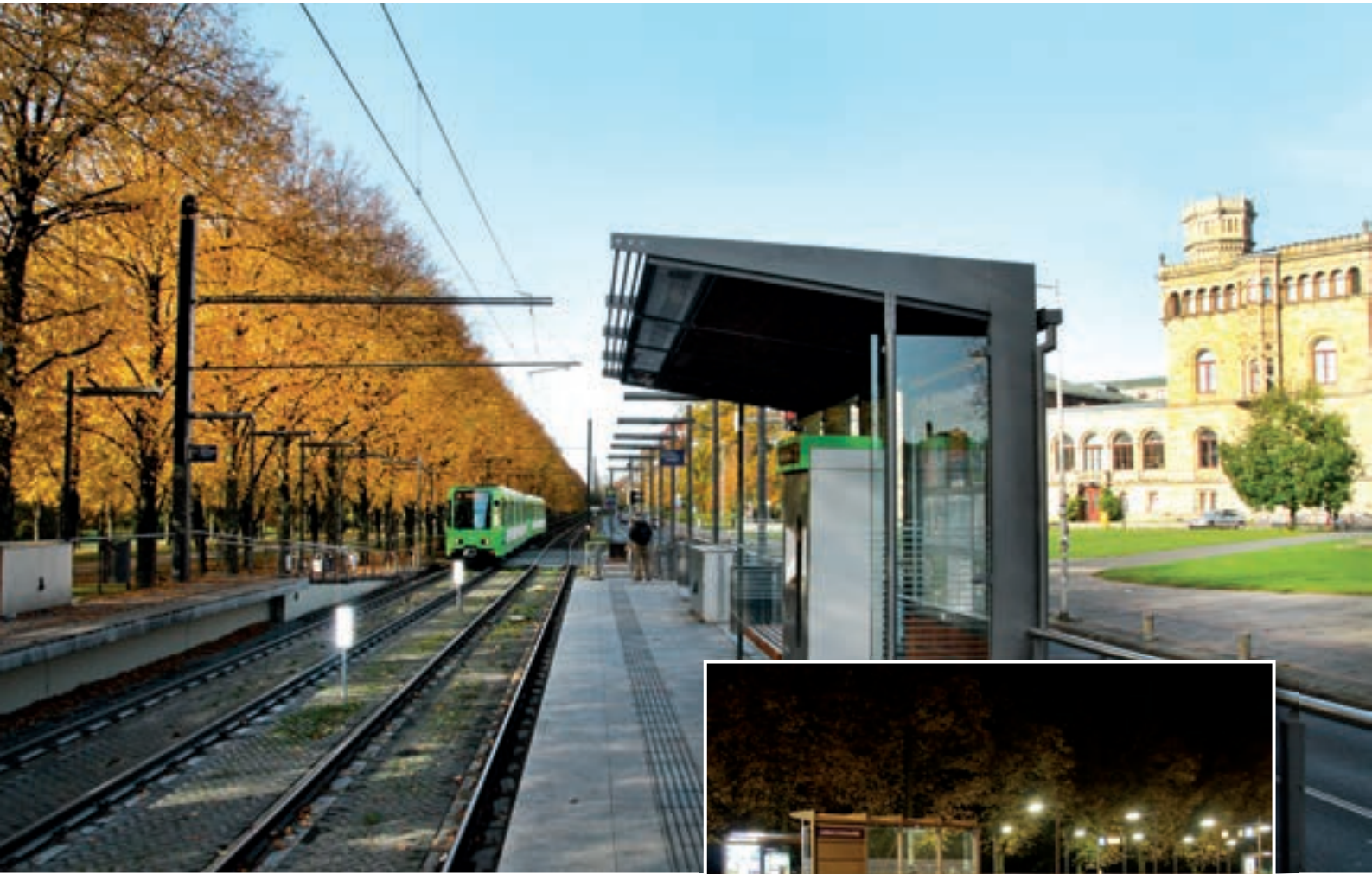
Stadtbahnhaltestellen und Gleisbau in Hannover-Herrenhausen
