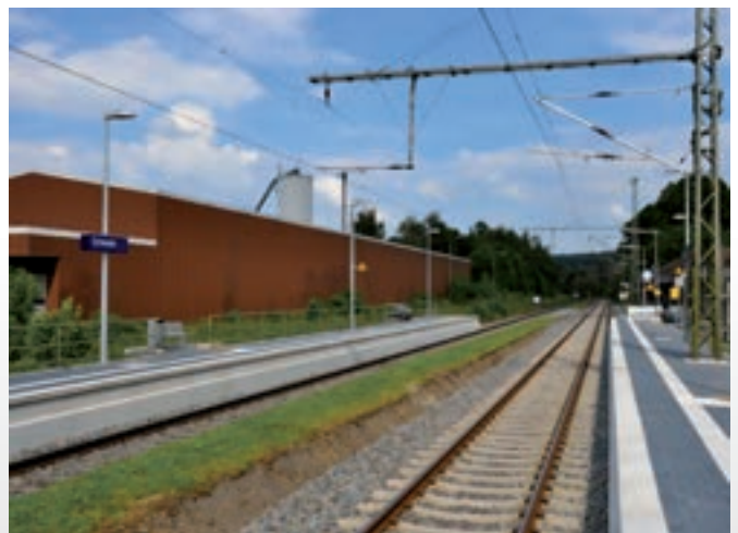
Pilotprojekt mit 2 m Bahnsteigkantenelementen im Bahnhof Schieder
