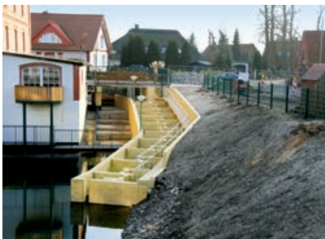
Fischaufstieg in Liebenau aus eingefärbtem Beton
