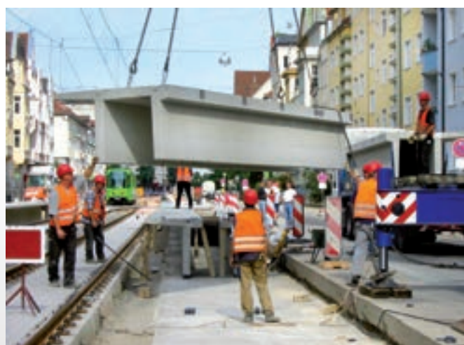
Montage eines Hochbahnsteiges aus Stahlbetonfertigteilen
