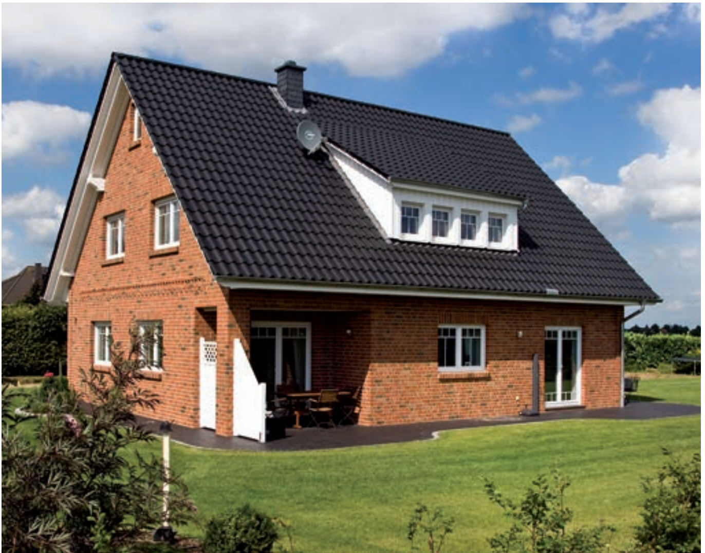
Elegantes Wohnen auf dem Lande – durchdacht und massiv gebaut
