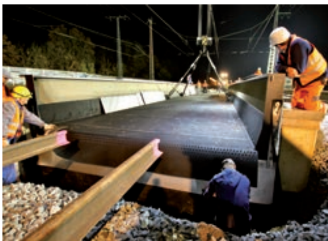
Brückenerneuerung an der Eisenüberführung „Gustav-Brandt-Straße“, Hannover
