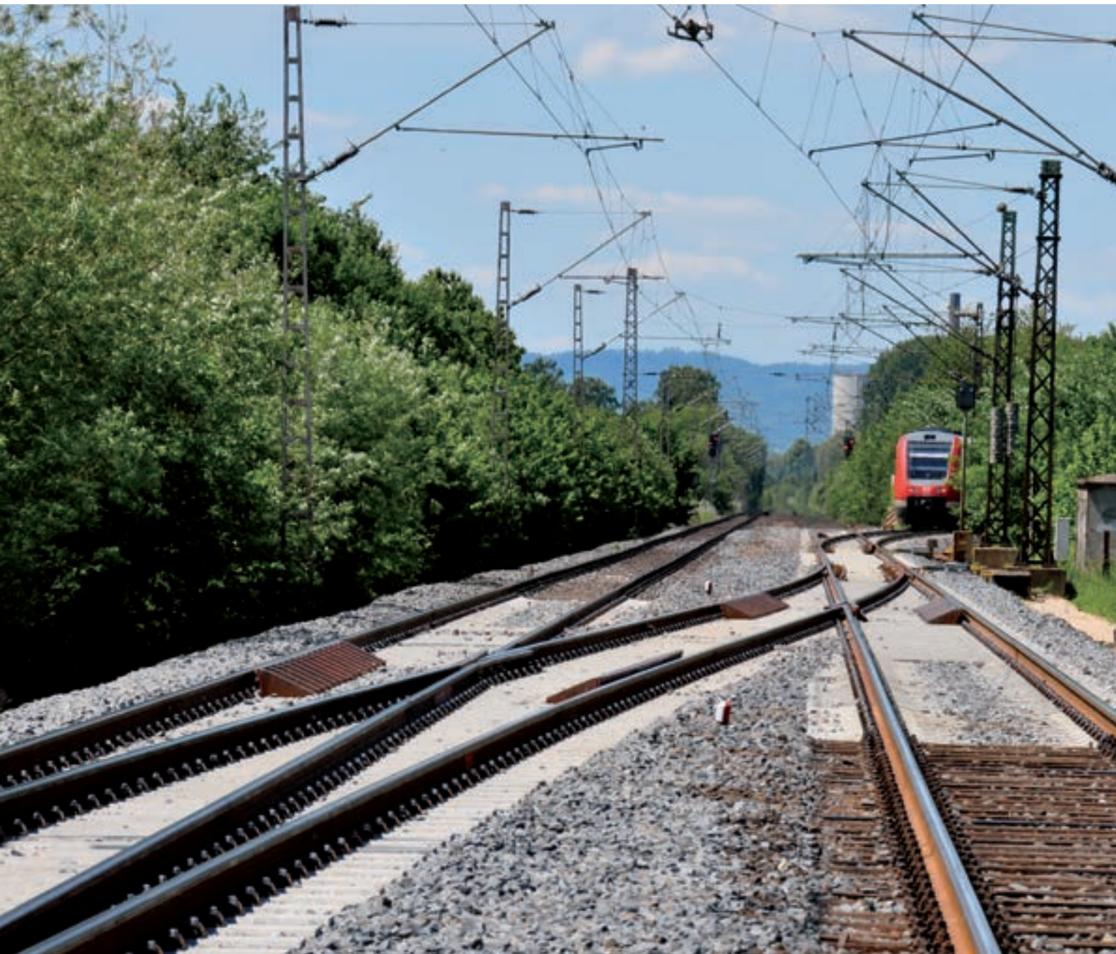
Erneuerung von zwei Weichen „Abzweig Rössing“ auf der Strecke Hildesheim/Nordstemmen
