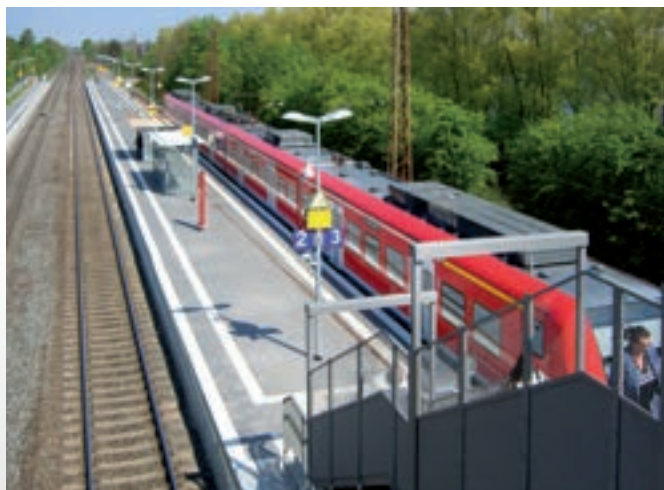
Fußgängerbrücke und Bahnsteig im Bahnhof Barnten
