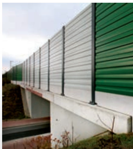
Eisenbahnbrücke Wunstorf „Barnestraße“ mit integrierter Lärmschutzwand
