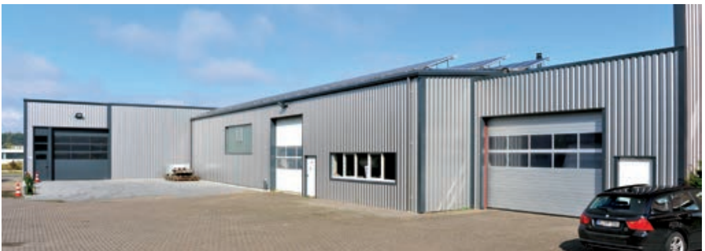
Erweiterung und Modernisierung einer Prüf- und Lagerhalle
