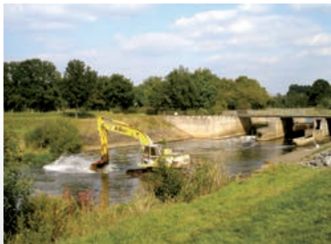
Beseitigung von Hochwasserschäden an drei Allerwehren
