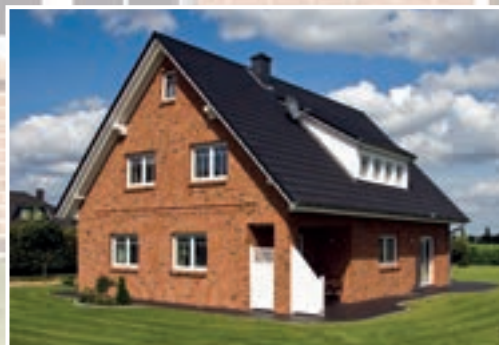
Neubau eines Einfamilienhauses mit Klinkerfassade
