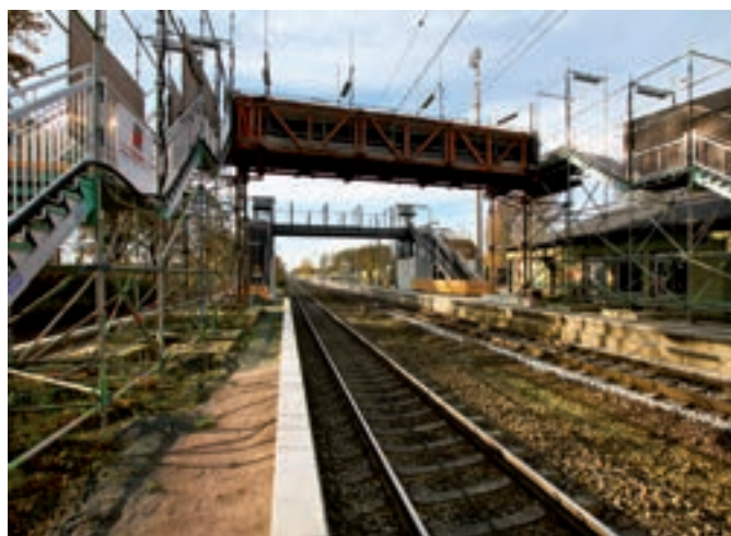
Bahnhof Sottrum (Brücke im Bauzustand)
