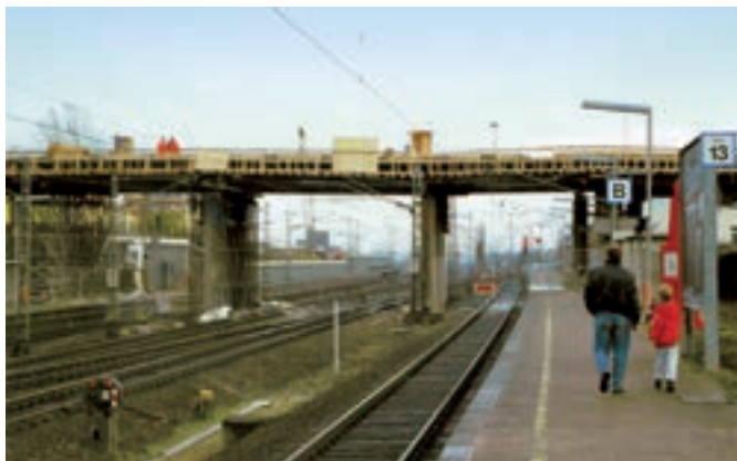
Mehrfeldbrücke über einen Bahnhof (1997)
