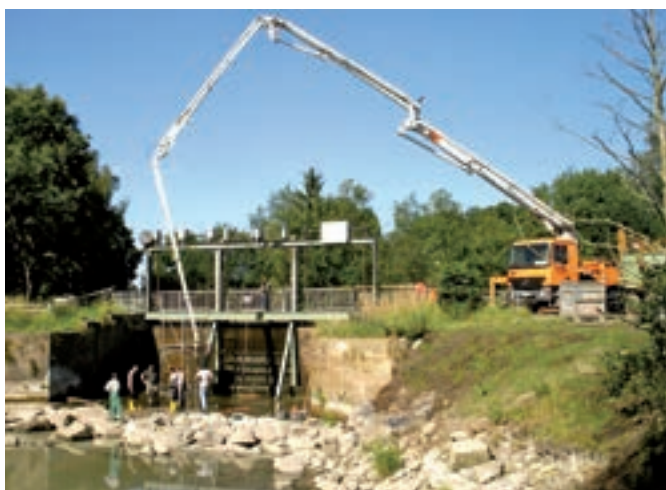
Wasserbauarbeiten an der Innerste und an der Gande
