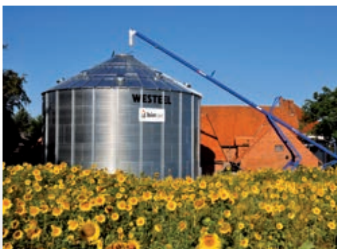
Erd- und Fundamentarbeiten für ein Getreidesilo in Nordstemmen
