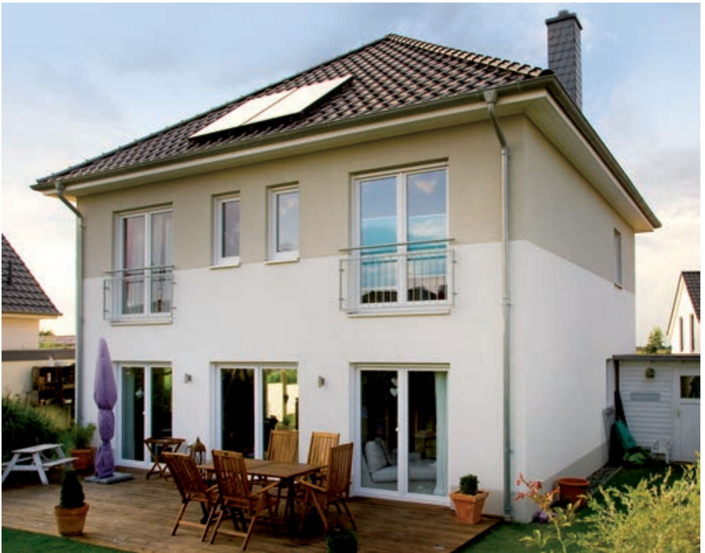
Stadtvilla auf zwei Vollgeschossen und ohne Dachschrägen in den Räumen
