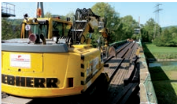
Zweiwegebagger im Einsatz
