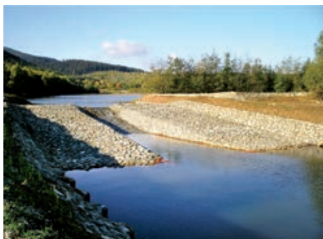
Herstellung der Durchgängigkeit für Fische und andere Lebewesen an der Gelmketalssperre im Harz
