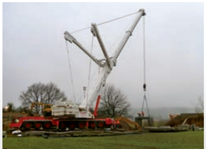
Einbau von Brückenfertigteilen
