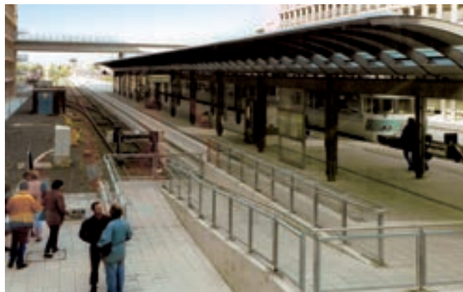
Neubau Bahnsteige in Wilhelmshaven (1997)
