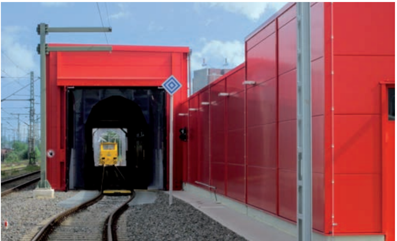
Die modernste Waschanlage der Deutschen Bahn AG wurde durch die A.F. Gewerbebau in Hallenbauweise in Münster erstellt und 2013 in Betrieb genommen. 40 Prozent des benutzten Wassers werden recycelt.
