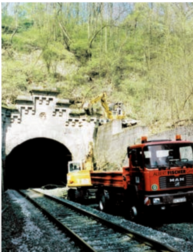
Sanierung Tunnelportal bei Kreiensen (2003)
