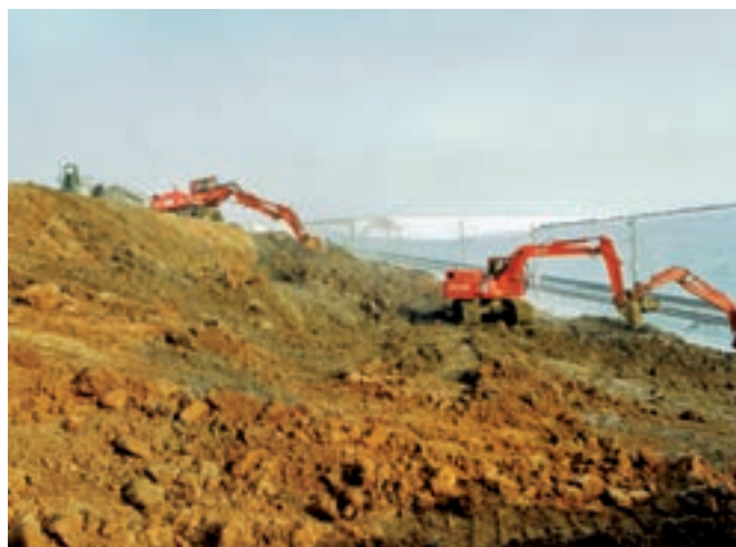
Sanierung Böschungsabrutsch (1993)
