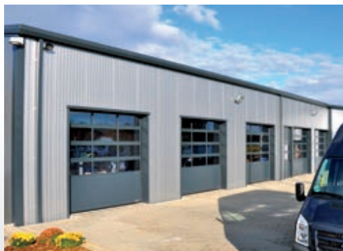
Kfz-Werkstatt mit Lager und Büroräumen
