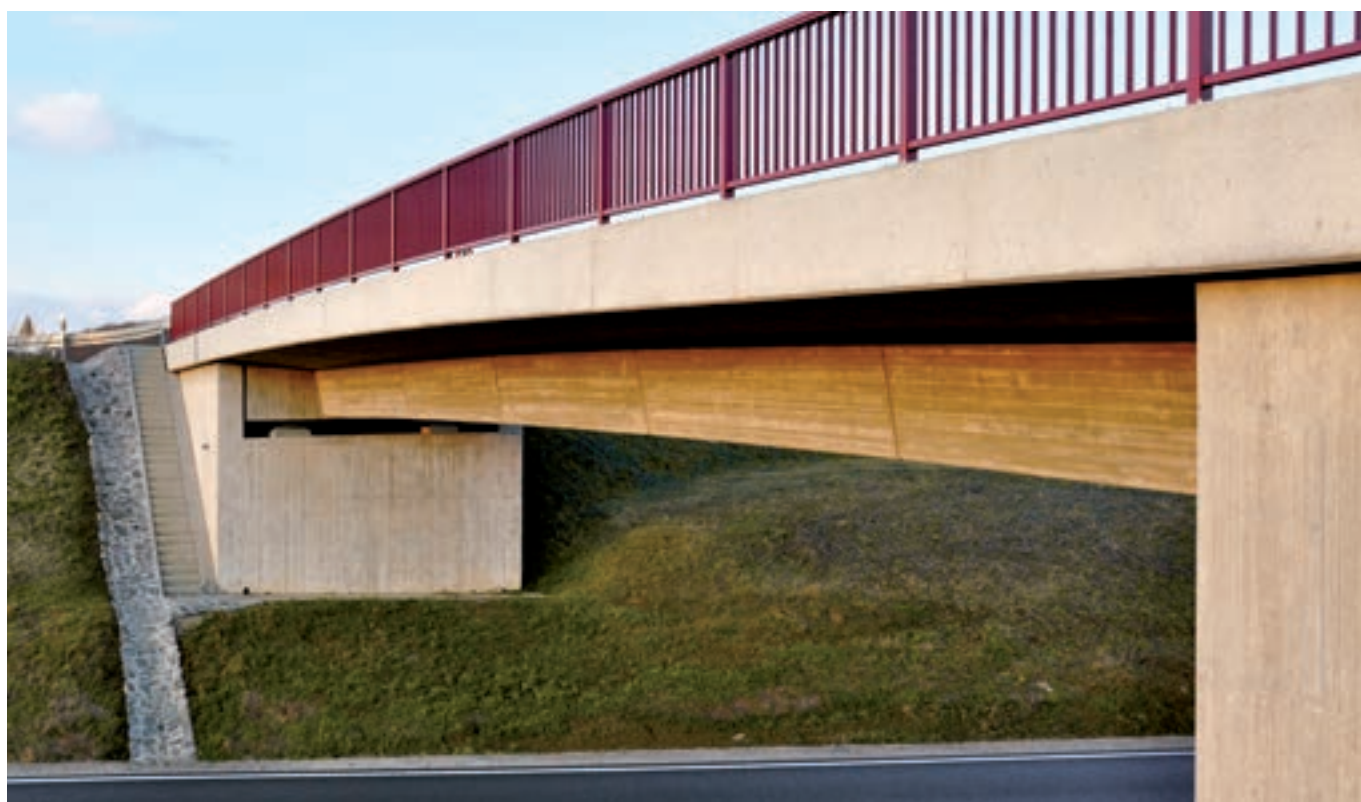
Spannbetonbrücke über die Bundesstraße 1 für die Ortsumgehung Mehle
