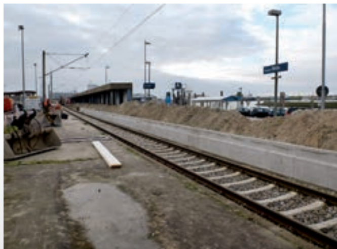
Erneuerung des Umsteigebahnhofes „Norddeich Mole“
